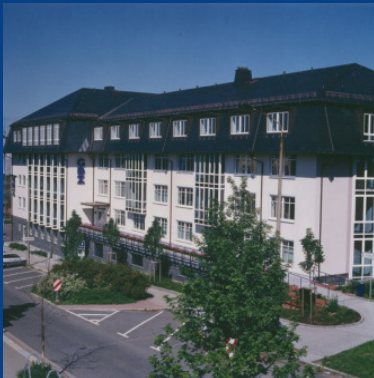
Technologieorientiertes Gründer- und Dienstleistungszentrum Annaberg
